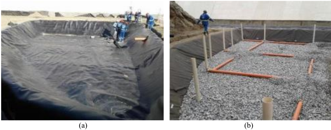
Figura 2: Instalação da (a) manta geomembrana de PEAD e da (b) malha hidráulica. Fonte: Phytorestore.
