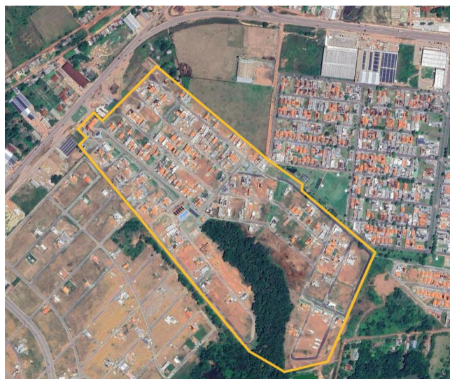
Figura 01: Imagem de satélite da localização do Vila Bella Residence Club (polígono amarelo). Fonte: Adaptado do Google Earth (2024).
